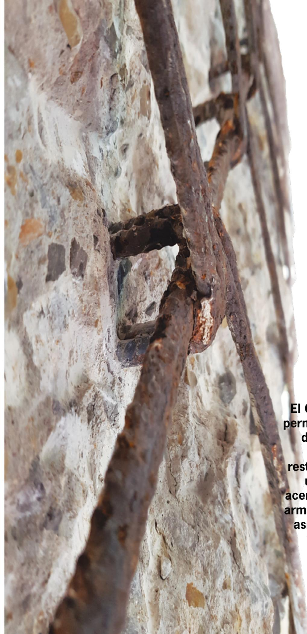
**El Código Estructural permite una limitación del ancho de fisura máximo, menos restrictiva en caso de usar corrugado de acero inoxidable en la armadura transversal, así como en la parte más exterior de la longitudinal.**
