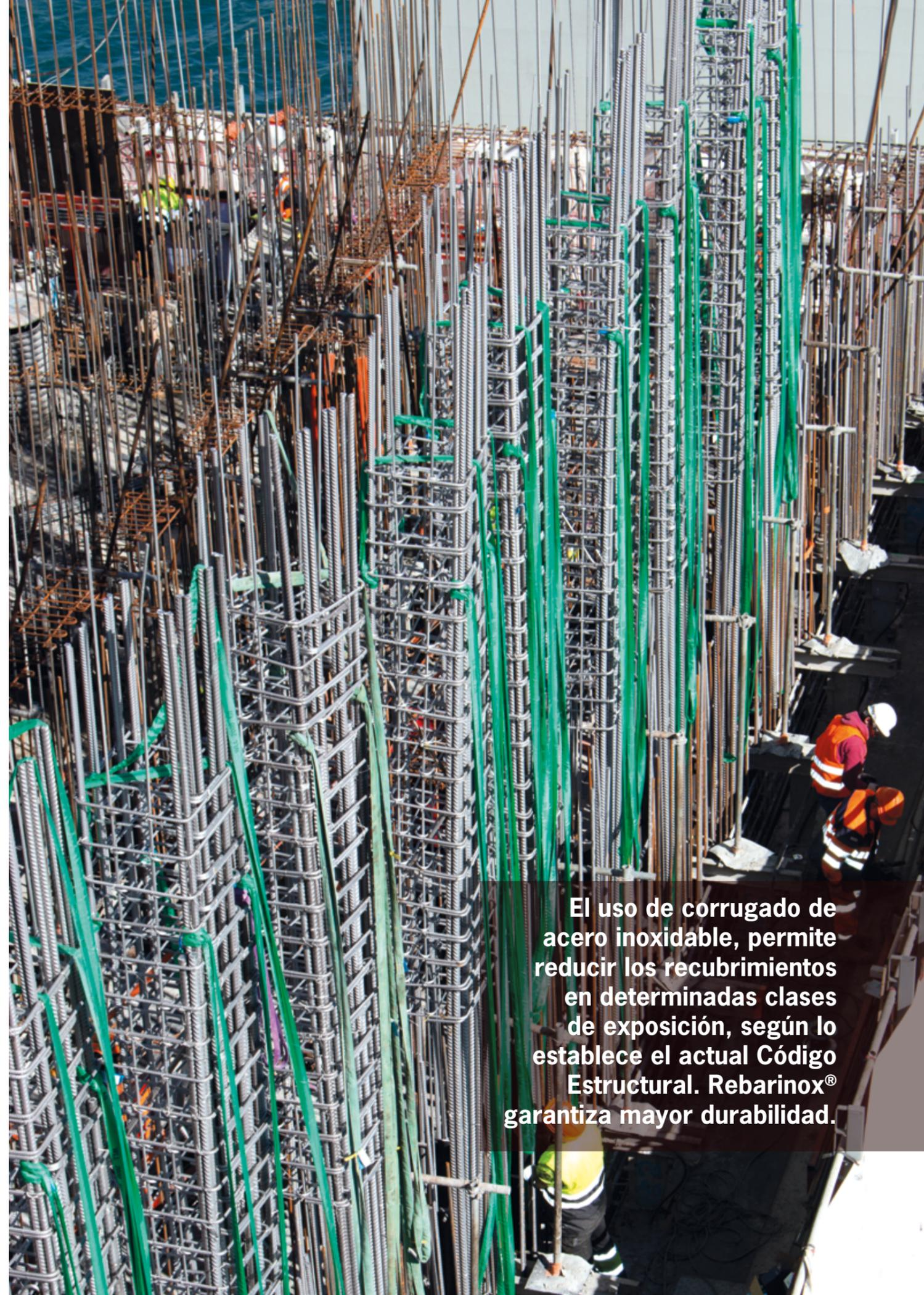
El uso de corrugado de acero inoxidable, permite reducir los recubrimientos en determinadas clases de exposición, según lo establece el actual Código Estructural. Rebarinox® garantiza mayor durabilidad.
