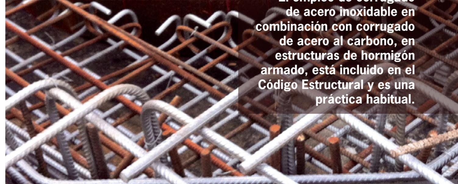
**El empleo de corrugado de acero inoxidable en combinación con corrugado de acero al carbono, en estructuras de hormigón armado, está incluido en el Código Estructural y es una práctica habitual.**
