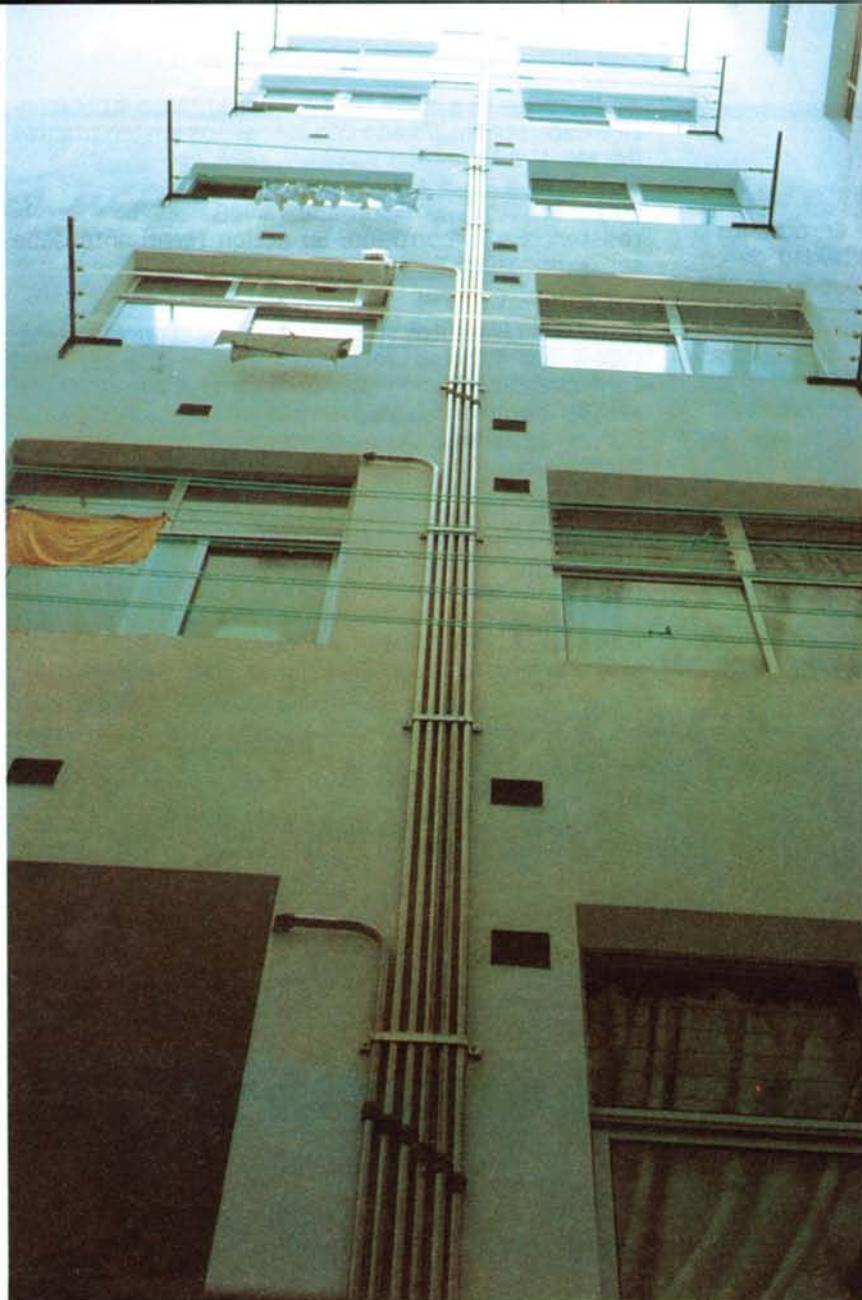
Tuberías en batería de agua sanitaria fabricadas en acero inoxidable AISI 316 de 28 mm de diámetro y 0,8 mm de espesor. Este tipo de tubería sanitaria ha sido instalada en viviendas de Palma de Gran Canaria donde el contenido en cloro del agua acostumbra a ser elevado.
