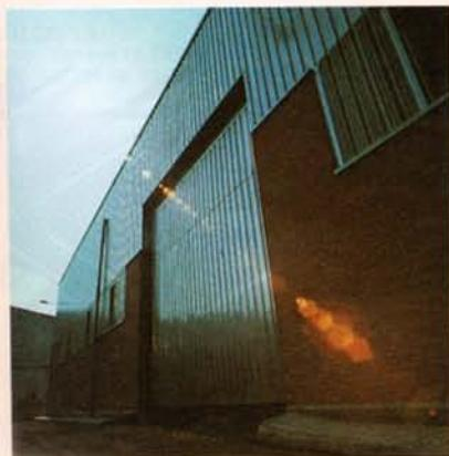
En la arquitectura de nuestro país, la utilización del Acero Inoxidable para la construcción de edificios es muy frecuente, pero no así en la construcción de cerramientos y cubiertas. Un ejemplo de ello es el edificio construido en Paterna (Valencia) por Aceros Boixareu como Centro de Servicios. La cubierta y cerramiento lateral está realizado en Acero Inoxidable AISI 316 con acabado 2B de 0,5 mm de espesor y en cuya construcción se han empleado un total de 16 toneladas.
