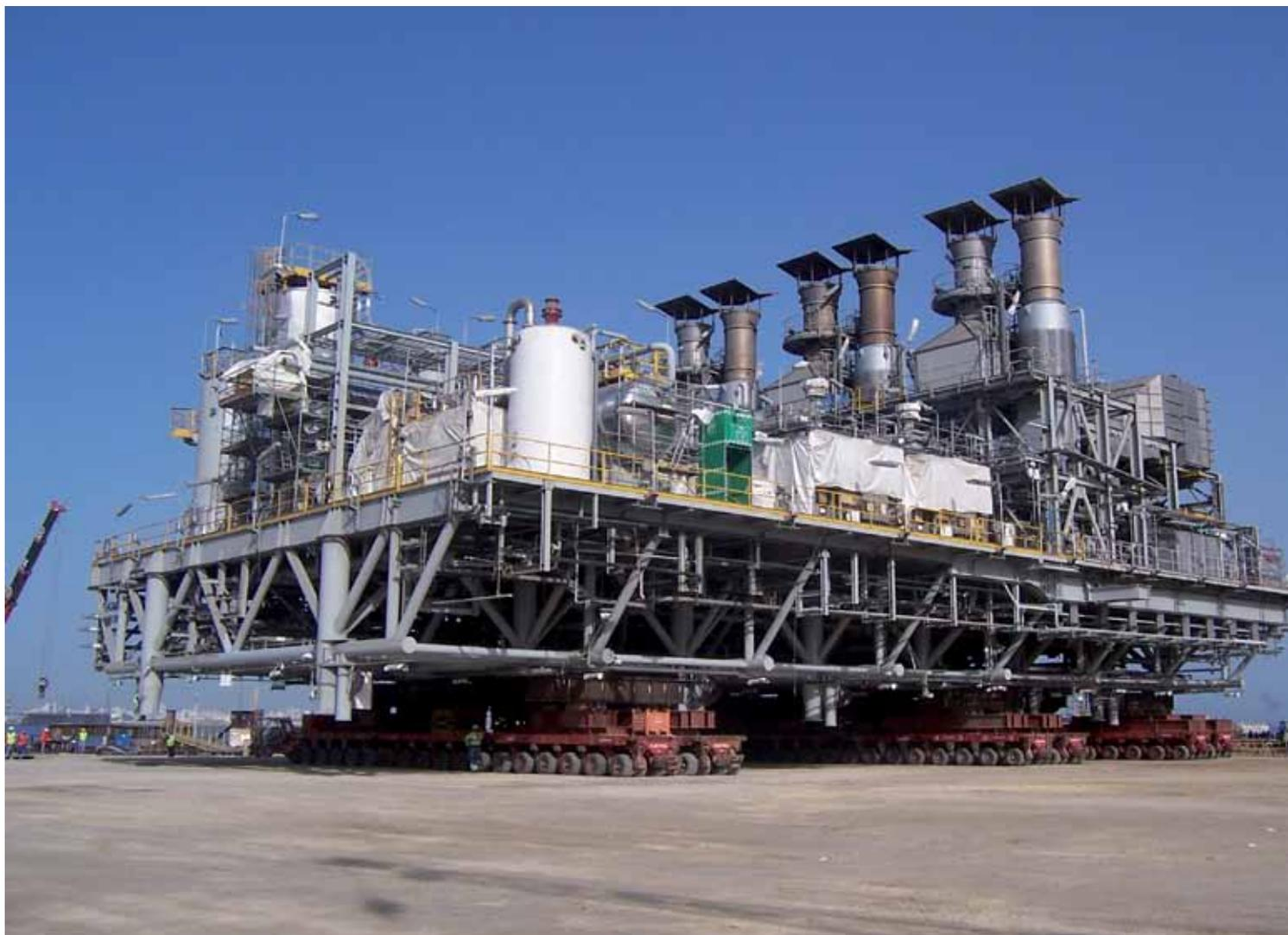
La Estación “Adriatic LNG” es una terminal destinada a la descarga, almacenamiento y regasificación de gas natural licuado. Con un tamaño de 47m de altura, 88m de ancho y 180m de largo, es la primera estación de este tipo con estructura fija soportada sobre suelo marino. Fue construida en Algeciras y arrastrada por cuatro remolcadores durante 16 días hasta llegar a Rovigo, en la desembocadura del río Po,
