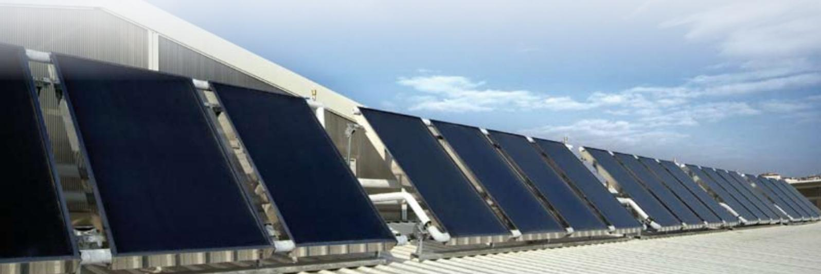
Ejemplo de instalación con 20 placas modelo OTS2000PI sobre tejado industrial para ACS situada en Manresa
