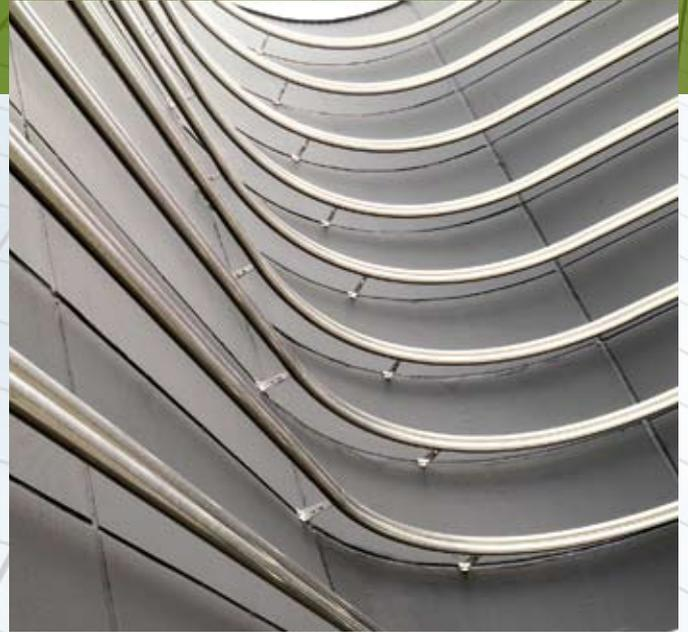
Detalles del tubo y de su anclaje a la fachada
