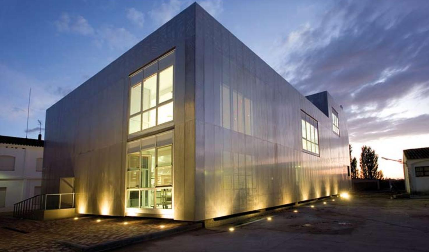
Se proyecta un segundo cerramiento exterior de chapa perforada de 2 mm de espesor de acero inoxidable austenítico AISI-304 mate (2B) sujeta por una subestructura de perfilaría de acero, sujeta a unas ménsulas de perfiles de acero anclados al canto del forjado. Este espesor garantizaba la planeidad de la fachada, ya que se hicieron muestras con menor espesor y no se obtenían resultados aceptables. La perforación de la chapa es de 10 mm de diámetro con
