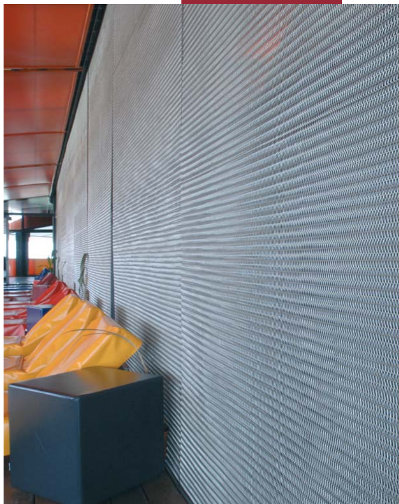
Detalle de la malla de acero inoxidable que separa la piscina de la zona de relax
