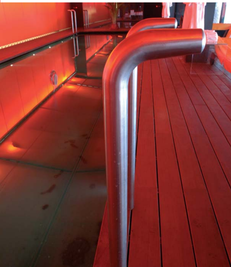
Detalle de la escalera de acceso a la piscina
