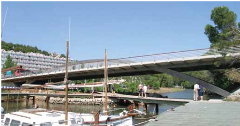
Figura 4. Vista general del puente sobre el torrente de Algendar.
