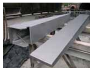
Figura 1, 2 y 3. Tratamiento de soldaduras mediante pasta decapante. Aplicación de chorreado superficial. Aspecto final de la superficie tras los tratamientos superficiales.
