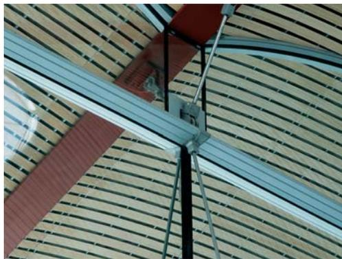
Detalle anclaje superior del "Kipper-truss"
