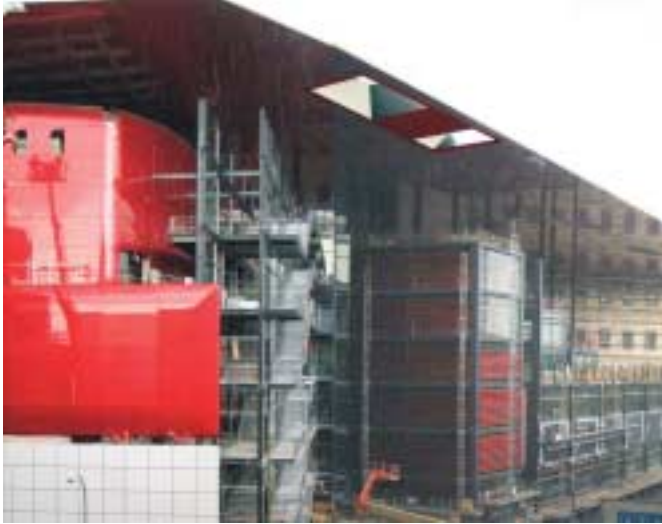
Fotografía 1: Detalle ampliado del lucenario en cubierta.
