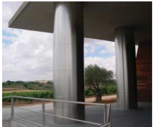
Fotografía 3: Bodega Pago Capellanes.
