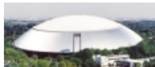
FOTOGRAFÍA 1: Cubierta en acero inoxidable de alta resistencia. Seibu. Estadio de béisbol
