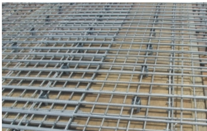
Puente en el Estado de Montana - USA
