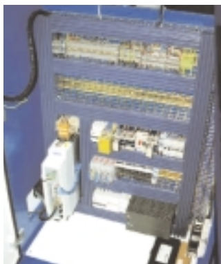
▲ Detalle del cuadro eléctrico perfectamente identificado, en el que destacan: l Servo PLC (LENZE), l Módulos de entradas y salidas, l Fuente de alimentación (SIEMENS) y l Protección (MERLIN GERIN)
