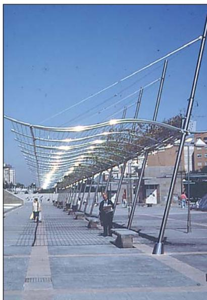
Está compuesta por módulos independientes trabados entre sí. Cada módulo está construido en acero inoxidable que, por sus características óptimas, su buena conducta en el exterior y la garantía de anti-corrosión, permite lograr la ausencia casi total de mantenimiento. A su vez, permite múltiples soluciones, de cubrición
