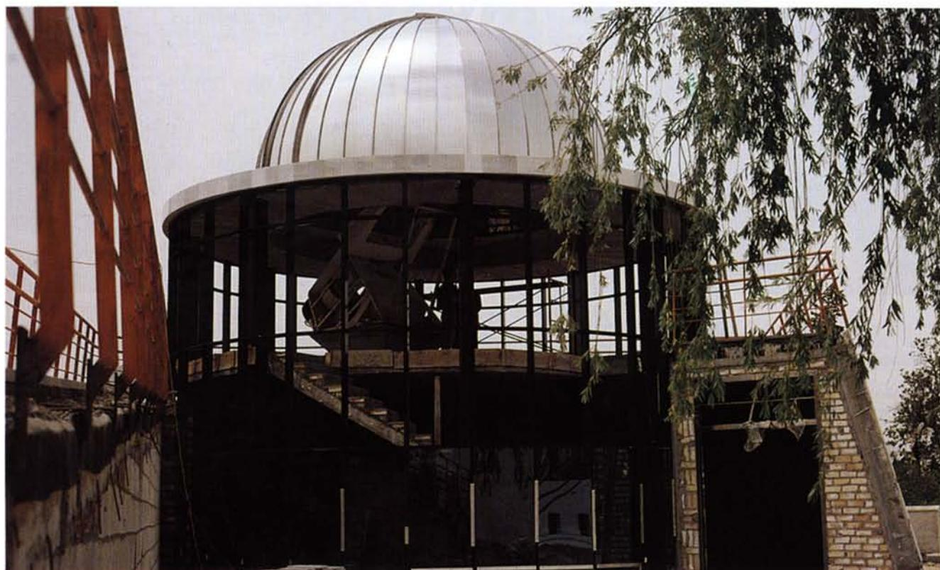
**L**a cúpula del telescopio del Parque de las Ciencias en Granada, ha sido íntegramente fabricada en acero inoxidable.
