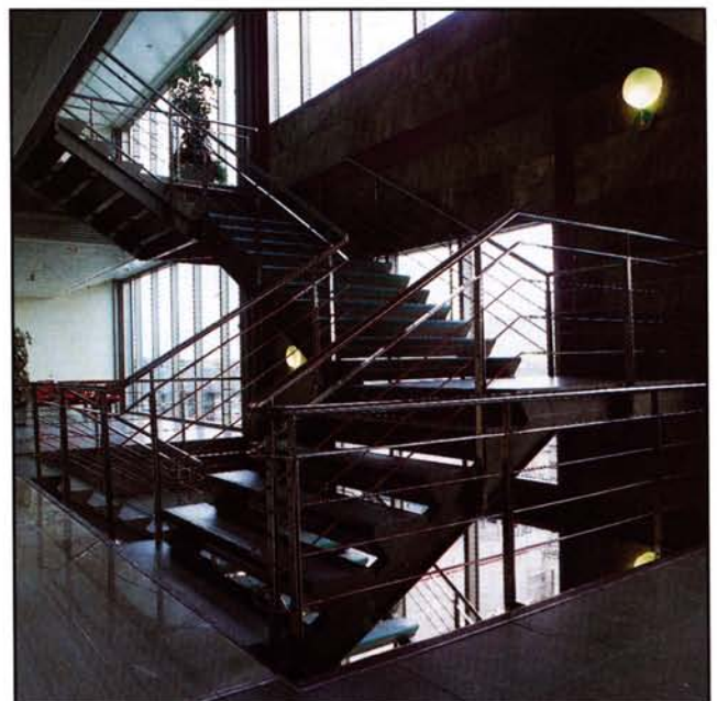
Detalle de barandillas
