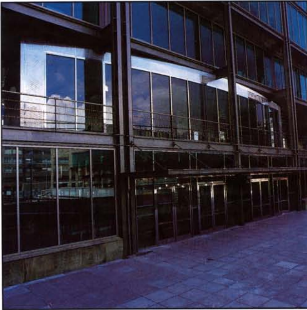
Acceso al Edificio
