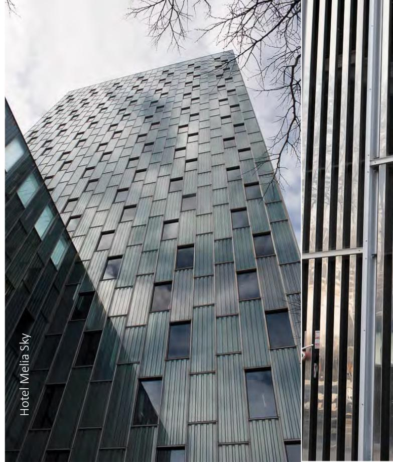
Tiene menor altura que el anterior, y está formado por tres capas, de nuevo un vidrio transparente al exterior, una chapa grecada de acero inoxidable, en este caso perforada, situada en la cámara intermedia, y una piel de vidrio interior (practicable, para mantenimiento). El último tipo de módulos que componen la fachada, es
