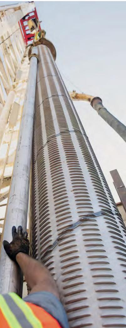
La tubería ranurada es un componente esencial en la construcción de pozos de agua. Sus hendiduras permiten que el agua subterránea se infiltre a través del perímetro de la tubería, manteniendo un flujo constante y eficiente. Al mismo tiempo, evitan el ingreso de partículas de tierra lo que mejora la pureza del agua y reduce el desgaste de los equipos de bombeo.
