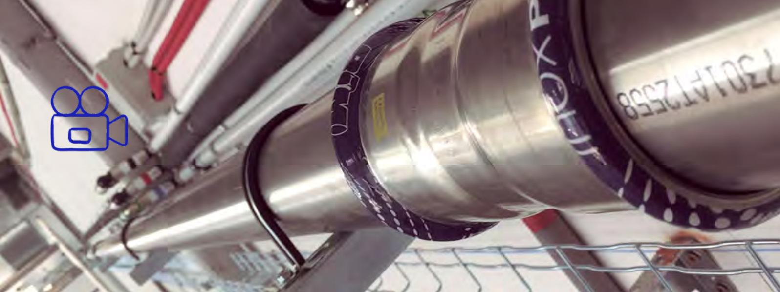
instalación. Destacar que la diferencia principal entre el accesorio de presar de gas, es la junta NBR color amarillo y la marca indentificativa que indica GT1 y GAS.
