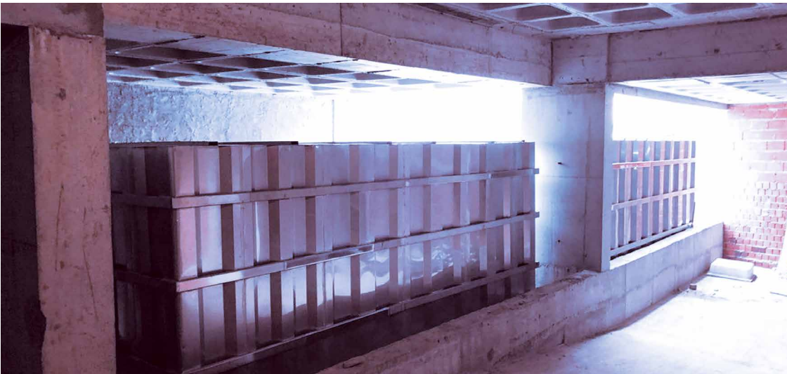
Instalación en obra Fosa séptica
