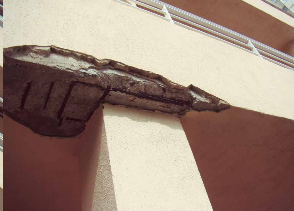
Figura 3: Detalle de desprendimientos
