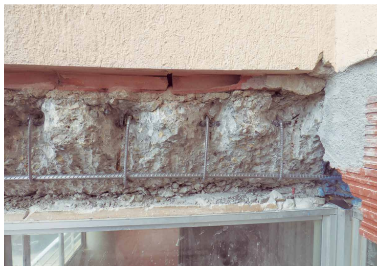
Figura 7: Colocación de armadura corrugada de acero inoxidable
