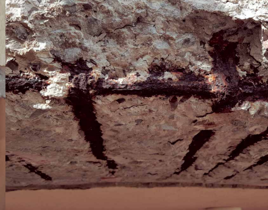
Figura 5: Fisuras en cara inferior de frente forjado
