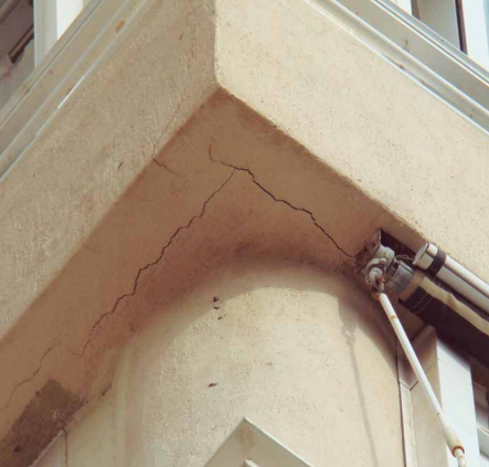
Figura 1: Fisuras en cara inferior de frente forjado
