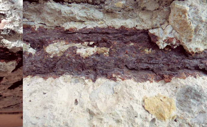
Figura 6: Fisuras en cara inferior de frente forjado
