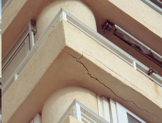
Figura 2: Fisuras en cara inferior de frente forjado
