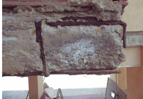
Figura 4: Frente de forjado afectado por oxidación
