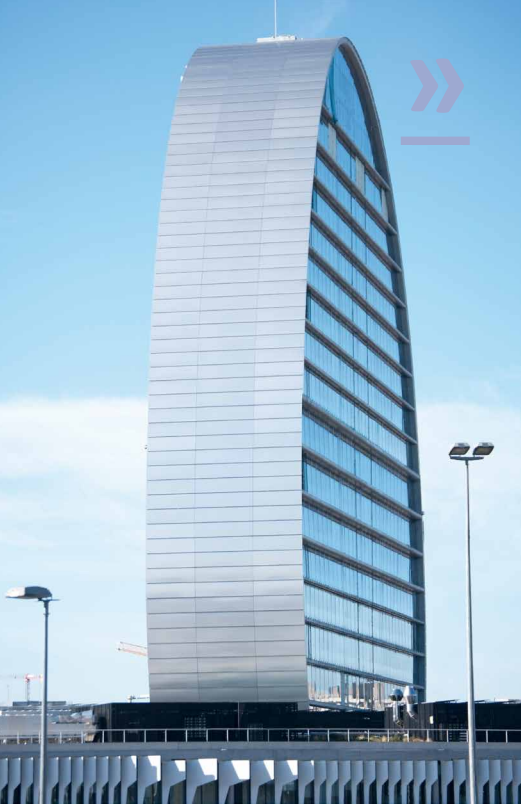
Sede del BBVA en Madrid. Piel de acero inoxidable pegada a cada panel con cinta 3M™ VHB™ (año 2015)
