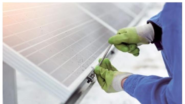
Acerinox fabrica el acero inoxidable AISI 430 (1.4016) que la empresa Investa en Polonia, utiliza en los elementos de sujeción de paneles solares que presentamos. Distintos modelos ajustados a los tipos de tejados más habituales, fabricados en este tipo de inoxidable que garantiza la suficiente resistencia a la corrosión y la regeneración
