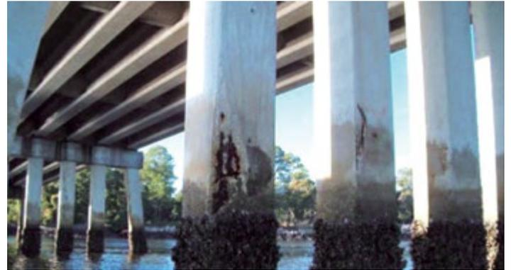
Figura 1 Desprendimiento de la cobertura de hormigón en la zona de carrera de mareas de una estructura de pilotes de hormigón pretensado a consecuencia de la corrosión de los cordones de pretensado. Ubicación: I-95 a su paso por el río Turtle en Brunswick, GA
