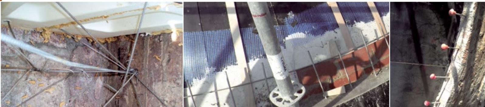
la estructura de la cúpula de la "Sala de Dia" estaba formada por dos cáscaras, una inferior de forma semiesférica, y otra superior, oval, ligeramente peraltada, contruídas con ladrillo macizo con un espesor total del sencillado más el doblado de 45 mm cada una, y levantadas con el sistema constructivo de bóveda tabicada. Ambas cáscaras arrancaban de un mismo zuncho formado por un perfil metálico de ala estrecha, IPN-80.
