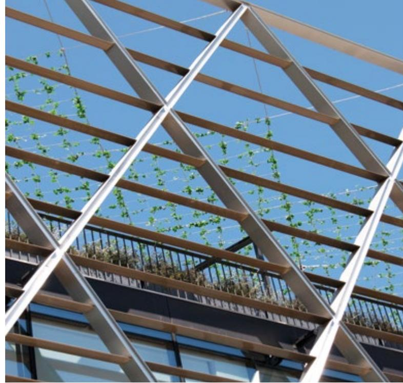
que se sirve de las últimas tecnologías para combinar una fachada transparente con una malla exterior. Esta proporciona control solar y minimiza el consumo de energía.
