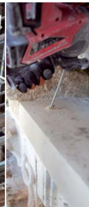
Anclaje en fábrica de piedra con varilla de acero inoxidable 12 mm y resina epoxi
