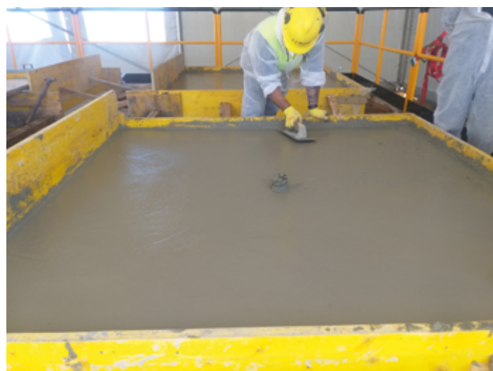
Figura 2: Losas ejecutadas con hormigón fabricado con EAI
