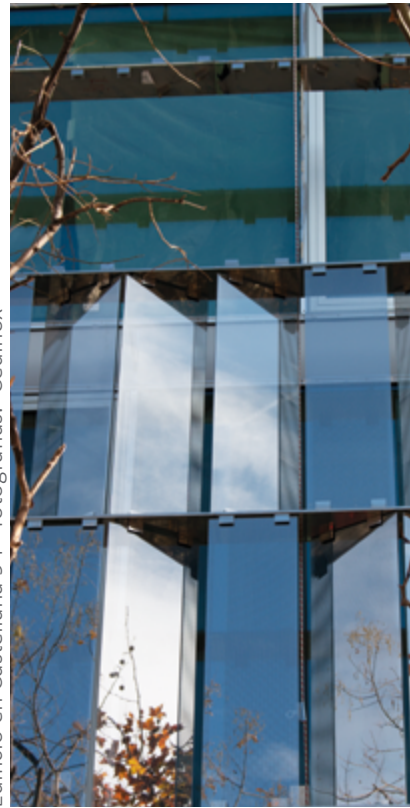
Edificio en Castellana 94- fotografías: Cedinox
