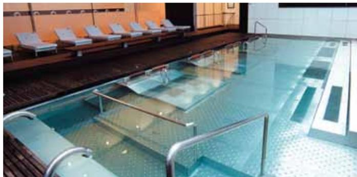
Bajo **mantenimiento**, no necesita un mantenimiento especial. El carácter higiénico del acero inoxidable y su superficie no porosa, que permite una menor suciedad, y reducción de depósitos orgánicos y bacterias, admite utilizar menos desinfectantes y limpiadores, aminorando los residuos dañinos para la salud y haciendo que el agua sea menos agresiva. El ahorro se hace evidente ya que su vaciado es necesario solo una vez al año.
