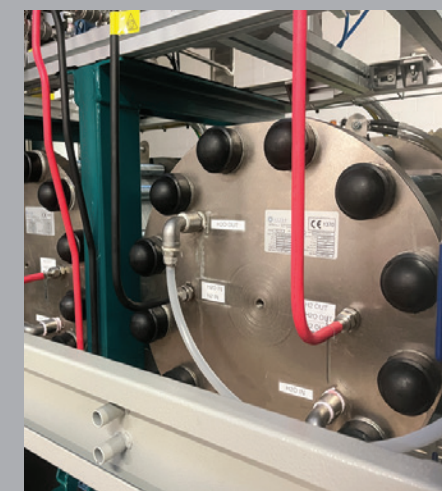
Un stack AEMWE de 10 kW instalado en el electrolizador
