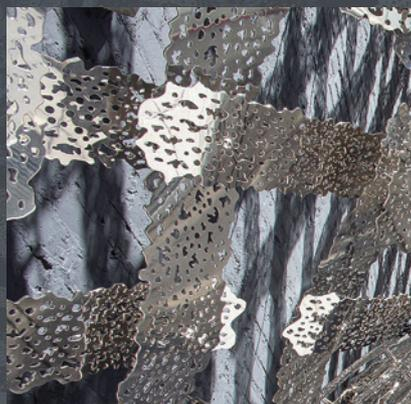
Las cintas de “follaje”, una compleja estructura y una proeza de la ingeniería, están cortadas con láser en acero inoxidable de aleación 316L (UNS S31603) de calibre 11 (3mm) y pulidas con un acabado no direccional n.º 4 en el reverso y un acabado espejo n.º 7 en el anverso.
