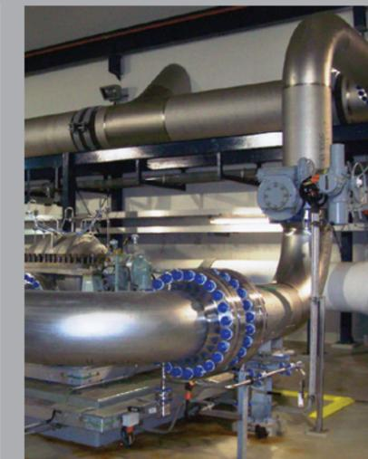
*Tuberías de acero inoxidable superdúplex de alta presión en la planta desalinizadora de ósmosis inversa de agua de mar (SWRO) de Queensland, Australia. Los aceros inoxidables dúplex y superdúplex son los materiales por defecto para las tuberías de alta presión en la mayoría de las plantas de ósmosis inversa del mundo debido a su combinación de alta resistencia y excelente resistencia a la corrosión.*
