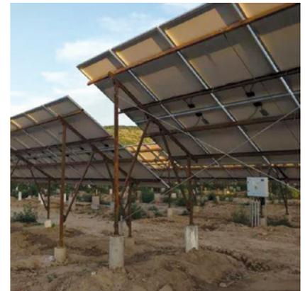
*Las estructuras de montaje consisten en pilotes para el montaje en el suelo, patas, columnas, vigas, rieles y abrazaderas, y otros accesorios de montaje.*
