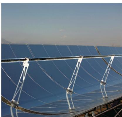
*El sistema de canal parabólico emplea reflectores que enfocan la radiación solar sobre un tubo receptor lleno de líquido, concentrándola por un factor de aproximadamente 100.*
