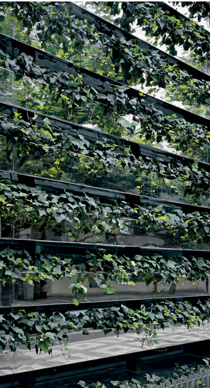
Las plantas en las cajas acabado espejo convierten la fachada de acero y cristal en una pared de vegetación.
