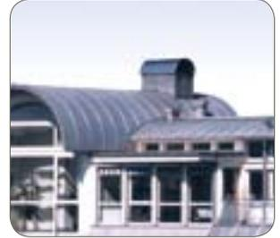
Tipo 430Ti (técnica de cubierta
