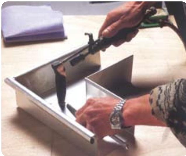
Soldadura de un canalón, tipo 430Ti revestido de estaño
