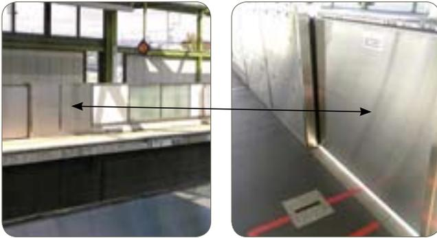
Barriera de seguridad en estación de ferrocarril, SUS430Ti, Japón.
