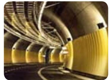
Paneles de revestimiento, tipo 430 revestido, Italia.
