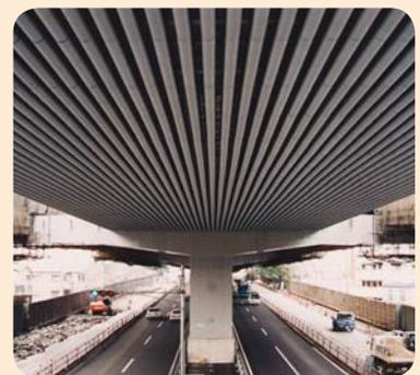
Schallabsorbierende Brückenverkleidung, Japan.
