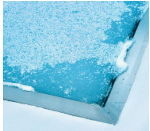
*Die Erdwärme reicht aus, um das Anfrieren des Eises an der Beckenwand zu verhindern.*
