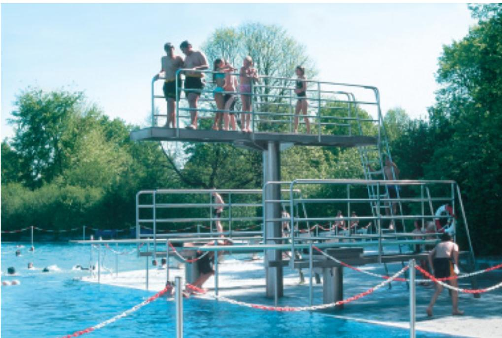
*Die tragende Konstruktion des Sprungturms ist vollständig aus Edelstahl Rostfrei-Profilen gefertigt.*
