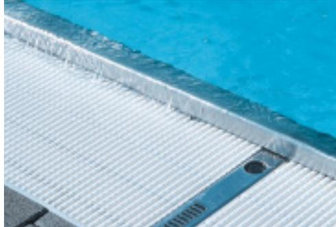
*Über die Überlaufrinnen wird das Beckenwasser in den Schwallwasserbehälter zurückgeführt.*
