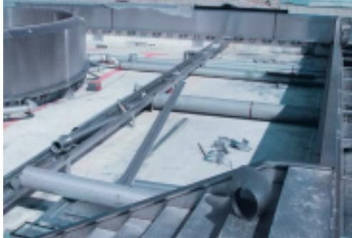
*Die nur 1,5 mm starken Bahnen des Beckenbodens werden auf einer Sandschicht verlegt.*
