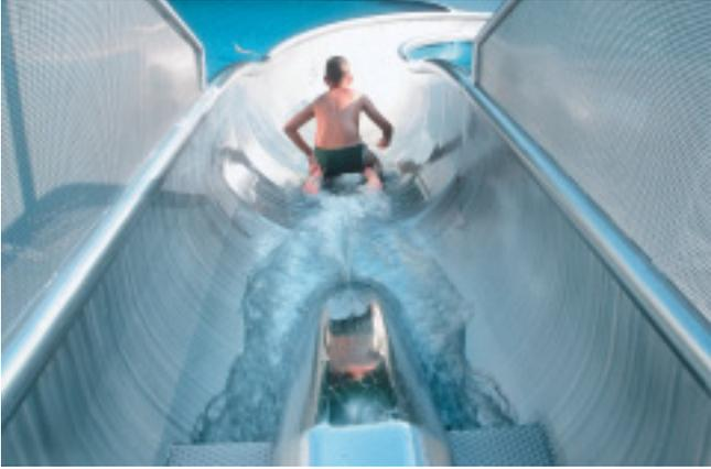
*Die Edelstahlrutsche stellt nach der Montage ein homogenes, in Rutschrichtung gleichförmiges Profil ohne spürbare Fugen dar.*
