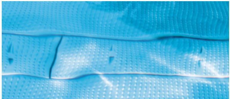
Aufgrund dieser korrosiven Beanspruchung wird der Werkstoff 1.4404 (ca. 17% Chrom, 12% Nickel, 2% Molybdän) eingesetzt. Auch Bauteile, die nur zeitweise Kontakt mit dem Beckenwasser haben, sind so vor möglicher Korrosion durch das chlorhaltige Wasser geschützt.
