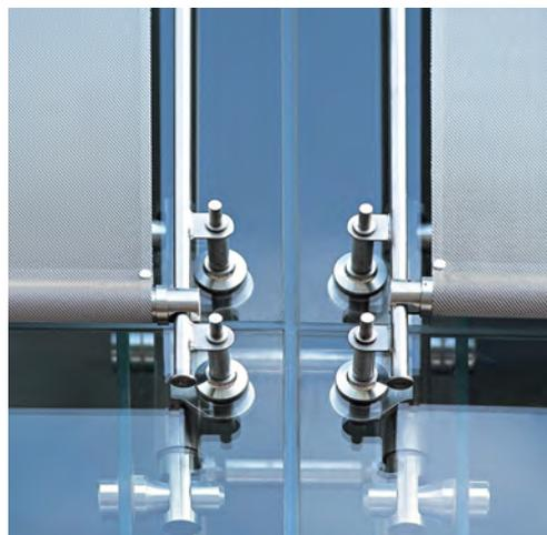
*Pantallas solares exteriores instaladas en rieles especiales de acero inoxidable ancladas a las fijaciones por puntos.*
