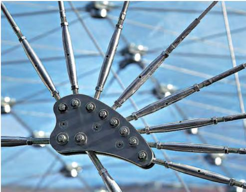
La tensión de los cables se ajustaba en los nueve conectores tipo araña.
