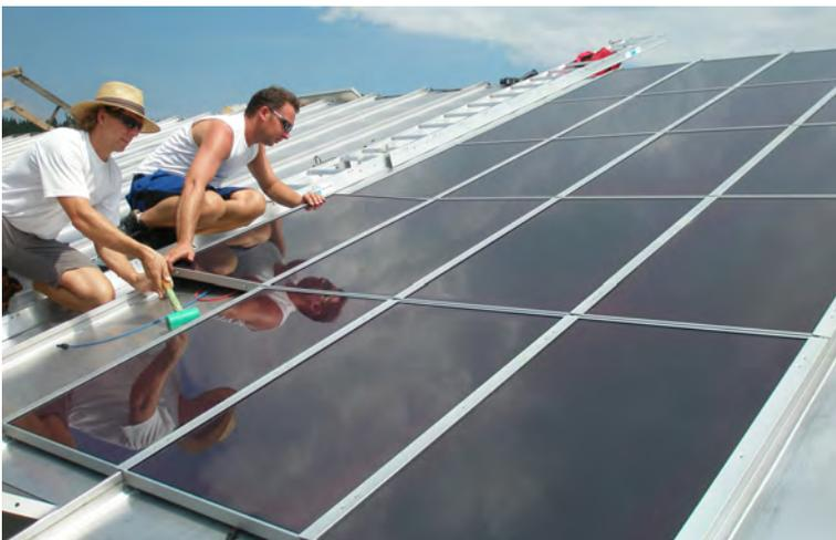
Die Solarpaneele werden oberflächenbündig zwischen den Edelstahl-falzen montiert.
