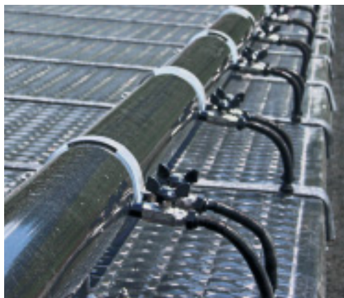
Fotos: Energie Solaire SA, Sierre, Schweiz (mitte, unten)
