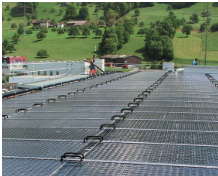
Die unverglasten, selektiv mit Schwarzchrom beschichteten Absorber zeichnen sich durch minimale Abstrahlungsverluste aus.
