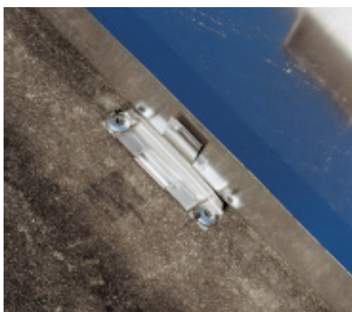
Tipi diversi di morsetti scorrevoli per i sistemi saldati.
