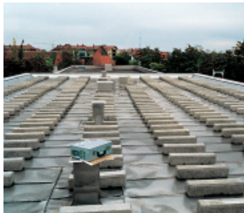
La messa in sicurezza può essere ottenuta sia mediante morsetti sia applicando dei pesi.
