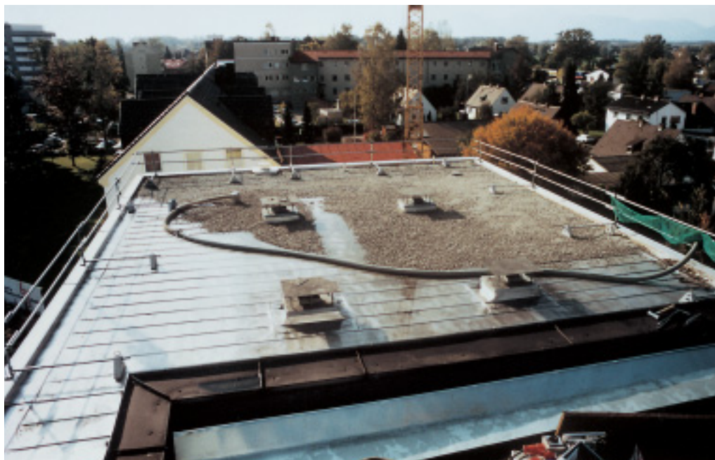
Uno strato di ghiaia è pompato sopra il tetto
