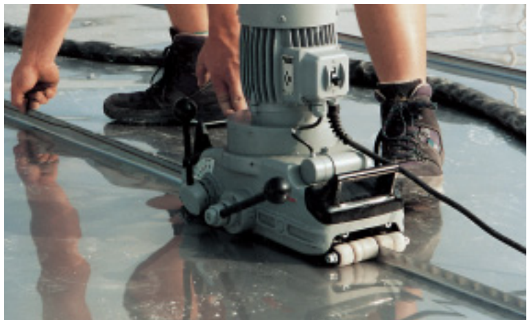
Obwohl nicht erforder-lich für die Dichtig-keit, wird die Schweißnaht zusätzlich gefalzt, um scharfe Kanten zu ver-meiden.
