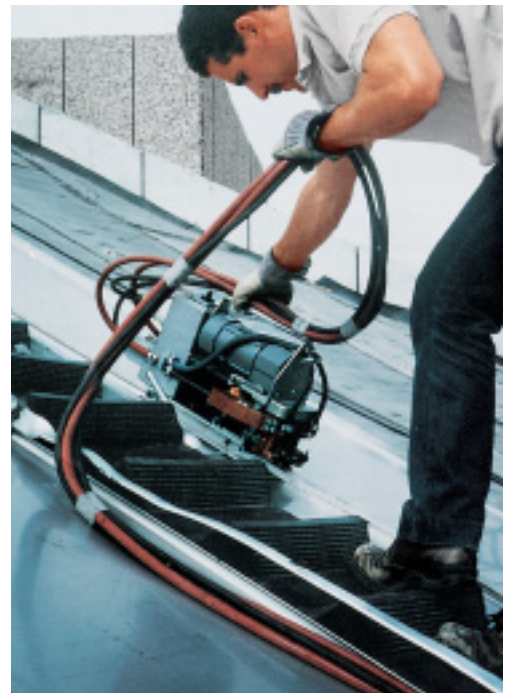
Rollnahtschweißmaschine mit wassergekühlten Elektroden.
