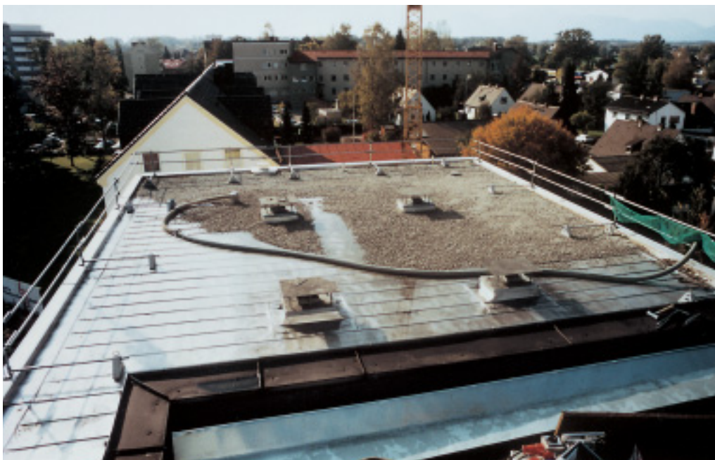
Aufbringung von Kies auf das Dach.
