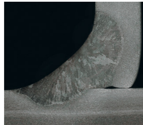
Der Ausschnitt zeigt eine konkave Schweißnahtüberhöhung, die auf beste mechanische Eigenschaften und Korrosionsbeständigkeit schließen lässt.
