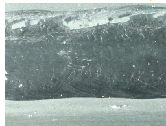
Nahaufnahme der Schweißnahtoberfläche
