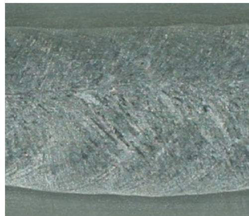
Nahaufnahme der Schweißnahtoberfläche
