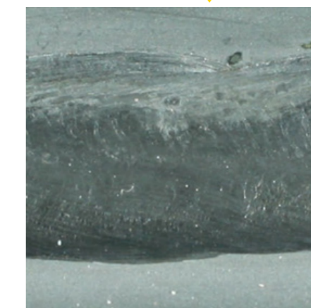
Nahaufnahme der Schweißnahtoberfläche
