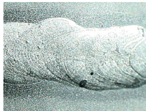
Nahaufnahme der Schweißnahtoberfläche; kleine Schlackepartikel sind sichtbar.
