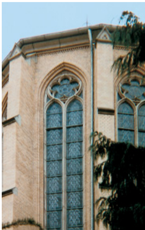
Uso de acero ferrítico estañado, calidad 1.4410, en las bajantes del edificio de una iglesia.
