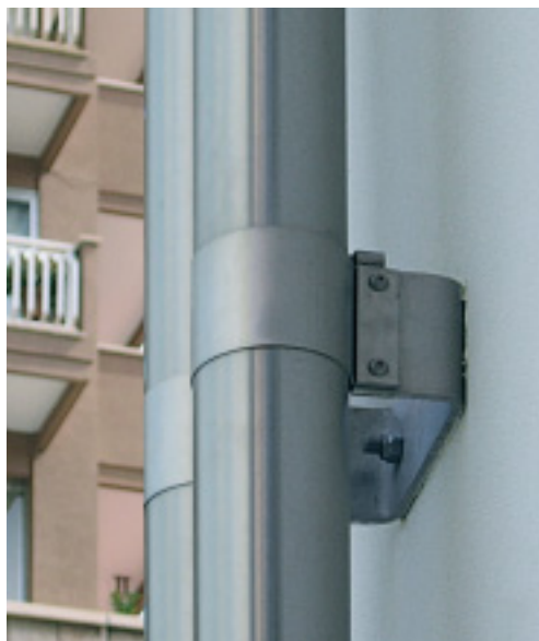
Drenaje de tejado en acero inoxidable cepillado que atraviesa el interior del edificio de un aeropuerto
