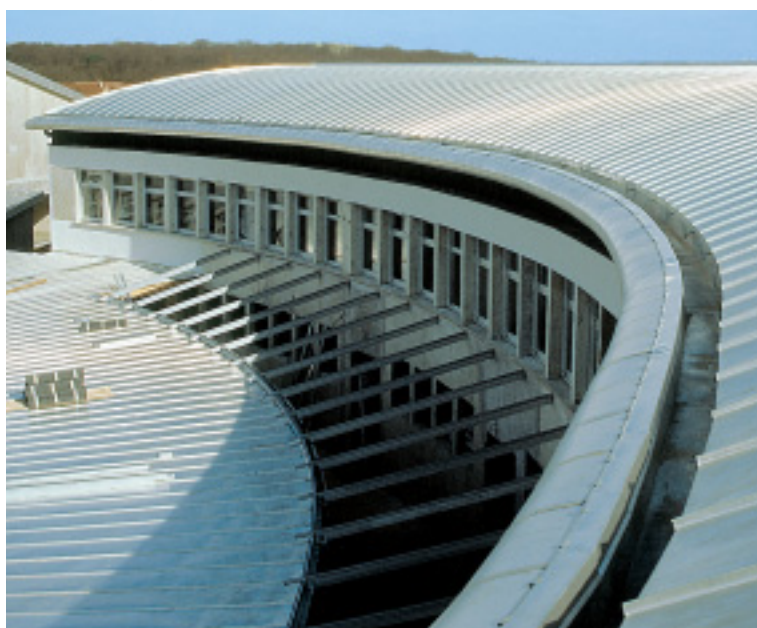
Canalón oculto en el edificio de una escuela en Allonnes, Francia
