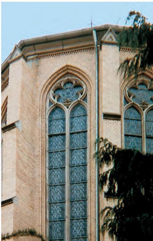
Verzinte Oberflächen werden oftmals für ältere Häuser eingesetzt und sind weit verbreitet bei Gebäuden, die unter Denkmalschutz stehen. Bevorzugt wird dieser verzinnte Edelstahl gerade bei bauhistorischem Kulturgut, bei dem die Dichtigkeit der Entwässerungsanlage über Generationen gewährleistet bleiben muss und gleichzeitig das Erscheinungsbild der alten, traditionellen Materialien anklingen soll (vgl. Kapitel 4.3).
