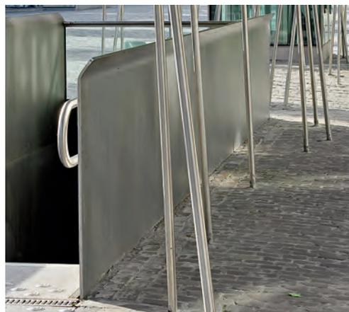
*Los paneles de las balaustradas situadas a cada lado de las escaleras están fabricados en acero inoxidable de 12 mm, doblados en la parte superior con el fin de incrementar su resistencia.*
