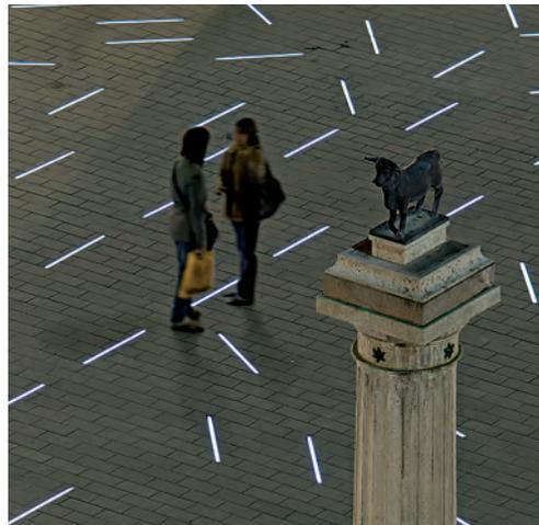
*Una caja de chapa de acero inoxidable de 2 mm (EN 1.4304) y una cubierta de vidrio laminado protegen las barras de iluminación instaladas al ras en los adoquines de basalto de la plaza.*
