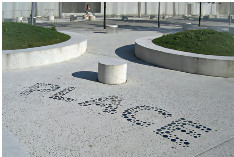
Schriftzüge aus nichtrostendem Stahl unterbrechen die mattgraue Betonoberfläche des Platzes und funkeln im Licht wie Kristalle.
