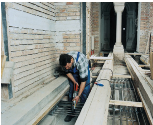
Bij het reviseren van verwarmingsinstallaties in monumentale gebouwen zijn de voordelen van een koud proces overduidelijk: er is geen enkel risico op brandgevaar. Foto: Geberit, Jona (CH)
