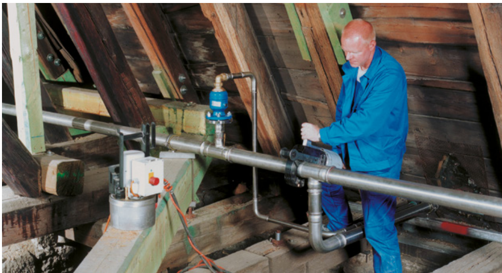
Persfitting-verbindingen worden bij omgevingstemperatuur op mechanische wijze tot stand gebracht en brandgevaar is daarbij helemaal uitgesloten. Foto: Geberit, Jona (CH)
