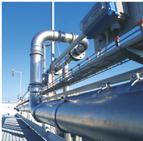
Roestvast staal persfitting-systemen zijn ook geschikt voor veel uiteenlopende chemische producten. Foto: Raccorderie Metalliche, Campitello di Marcaria, MN (I)
