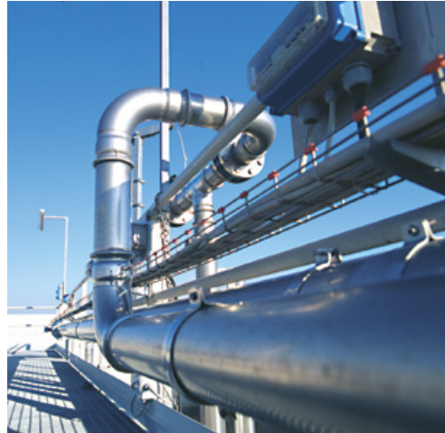
Pressfitting-Systeme aus nichtrostendem Stahl eignen sich auch für eine Vielzahl chemischer Produkte. Foto: Raccorderie Metalliche, Campitello di Marcaria, MN (I)
