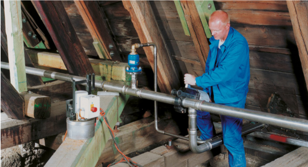
Als rein mechanische Verbindungstechnik läuft die Pressfitting-Verbindung bei Raumtemperatur ab; Brandrisiken werden ausgeschaltet. Foto: Geberit, Jona (CH)
