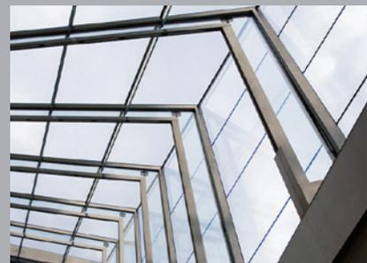
*Diseñadas por los arquitectos Stanton Williams, las estructuras de vidrio proyectan la luz solar en la estación ubicada debajo y están iluminadas por la noche, creando un entorno espectacular y seguro. Las estructuras de las dos entradas están separadas por una tira diagonal de cubierta de vidrio en el pavimento, que también permite que entre la luz natural y llegue al vestíbulo con taquillas ubicado debajo.*
