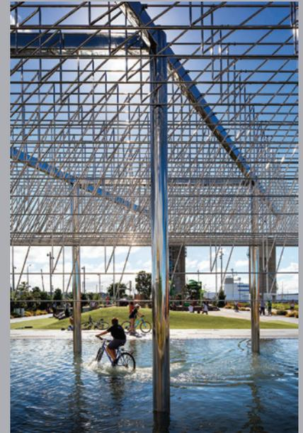
*En 1977 no era común usar el acero inoxidable tipo 316L con bajo contenido en carbono en estructuras. Los avances en la fabricación de acero han permitido que el acero inoxidable de grado "L" pueda obtenerse fácilmente. El tipo 316L asegurará igualmente que la obra de arte permanezca sólida y sin corrosión en el futuro.*
