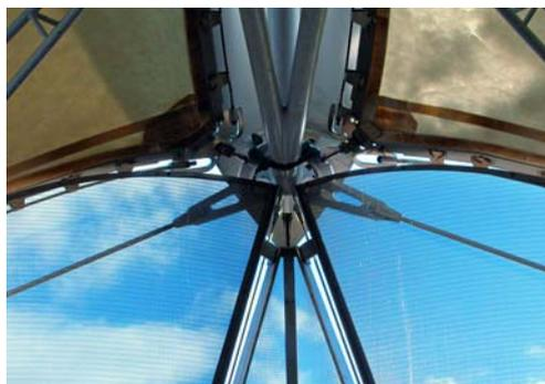
*Un capot transversal en inox recouvre les jonctions des membranes et permet la ventilation de l'espace intérieur.*
