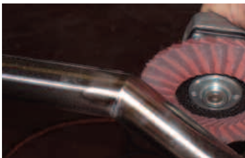
Úprava venkovního úhlu brusnými kotouči
