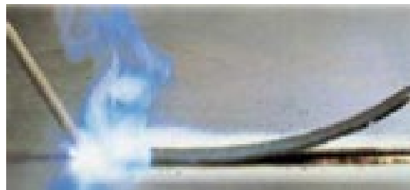
Fig. 2.4 Escoria separándose del cordón de soldadura
