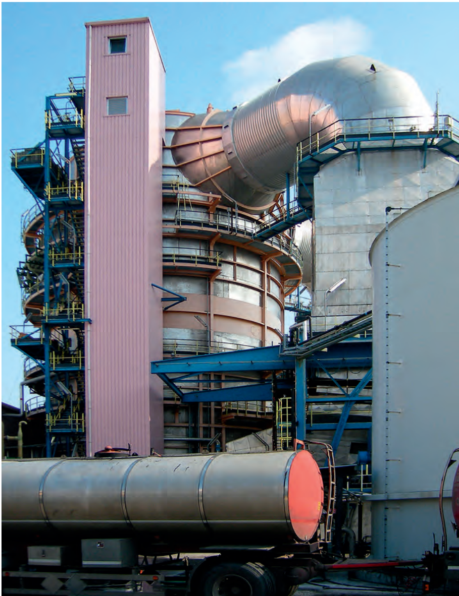
Impiego di un HPASS per uno scrubber flue gas. © Outokumpu
