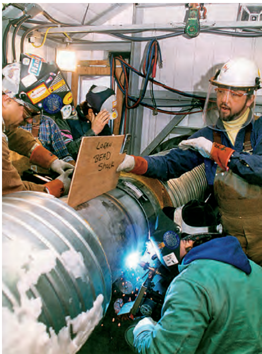
Serienschweißung von Großrohren für eine Pipeline aus nichtrostendem Stahl (Quelle: Arco Exploration and Production Technology)
