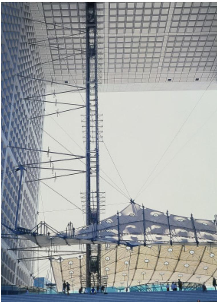
Pour supprimer la notion de cage d'ascenseur, la structure métallique est en forme de mâts de bateau superposés où tous les détails pour la maintenir sont dans le même esprit, aussi fins que possible.
